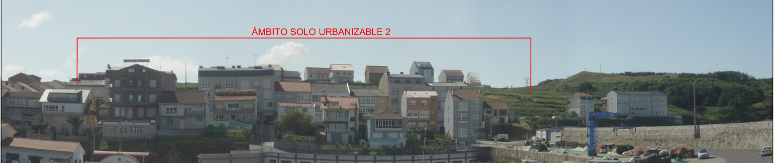
VISTA PANORÁMICA DENDE O DIQUE
